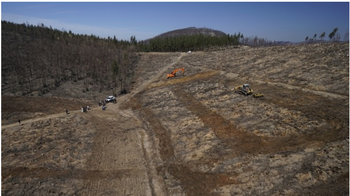
Vista aérea da área de demonstração: ao fundo vemos, máquina giratória cor-de-laranja prepara o terreno 'à cava'. A cor mais clara da terra denuncia a sua perda de qualidade. Mais próximo são aplicadas as boas práticas defendidas pela CELPA: um bulldozer efectua a gradagem da biomassa à qual se seguirá a ripagem à curva de nível.
